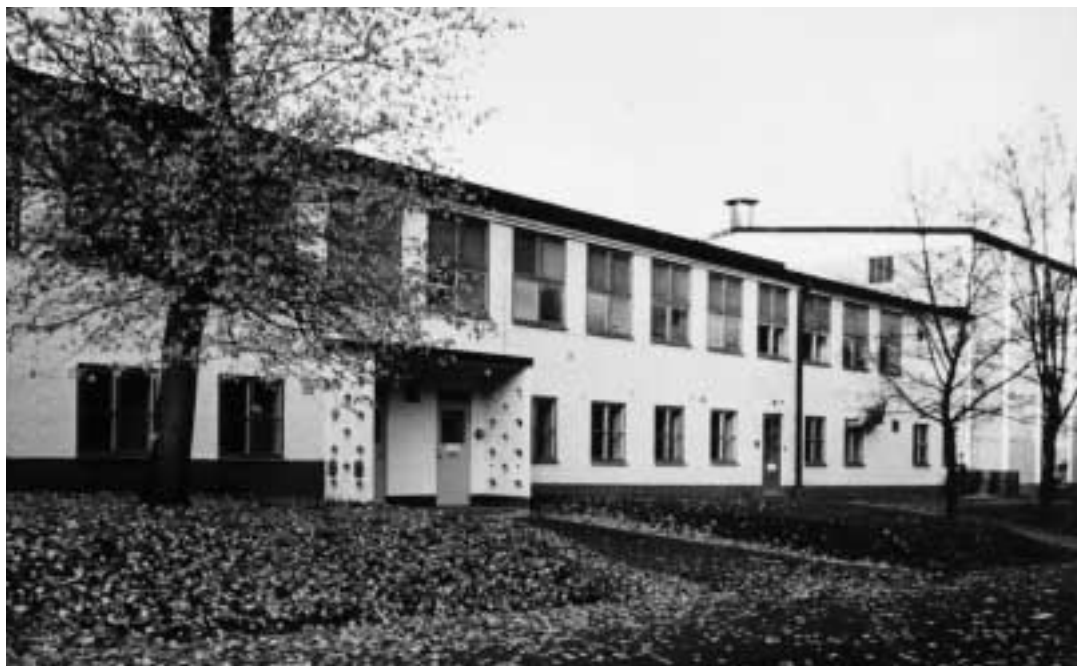
Del av byggnad 20, södra fasad med renrumsdelen till höger.
