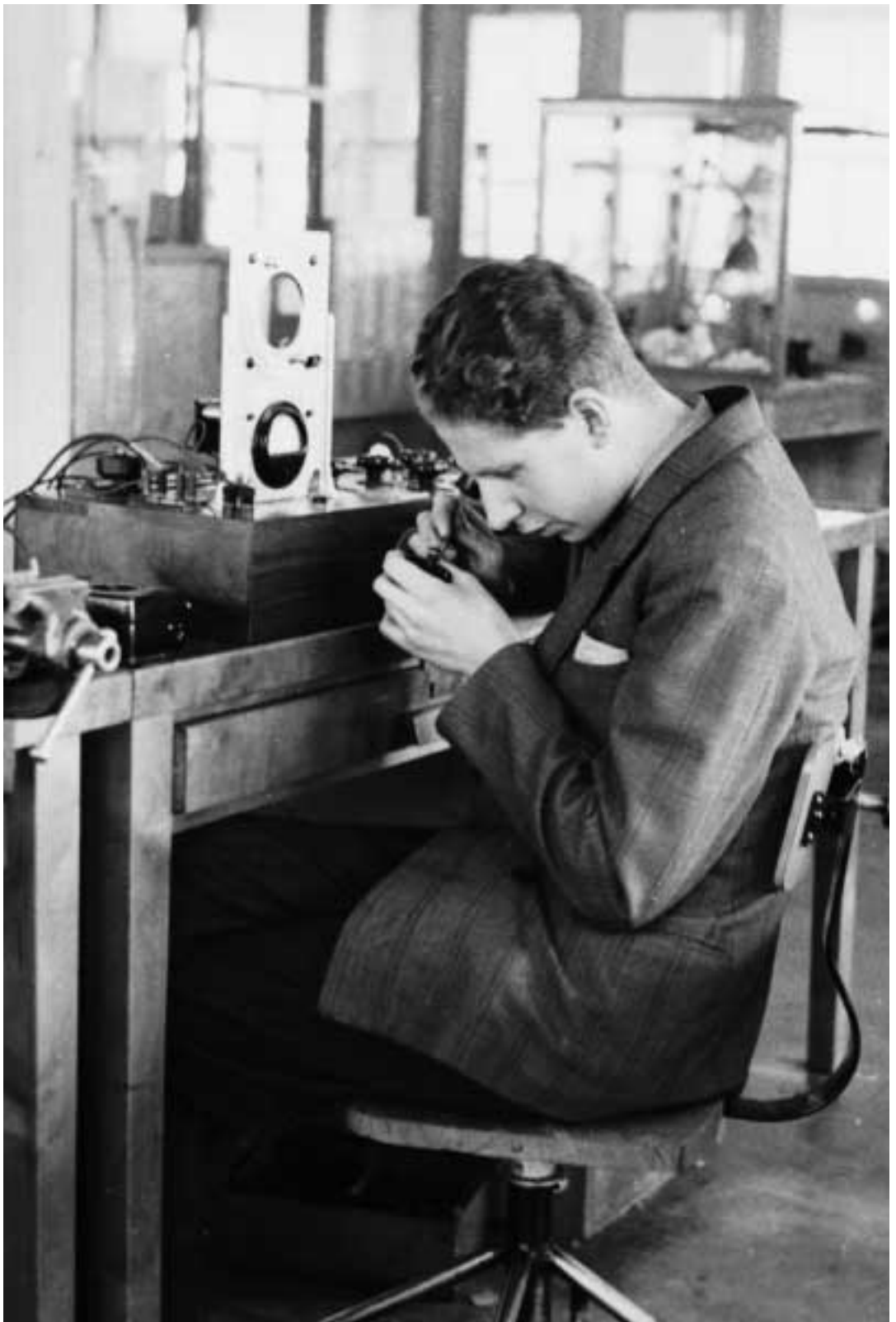
Bertil "Joe" Svensson i arbete med ett vridspoleinstrument.
