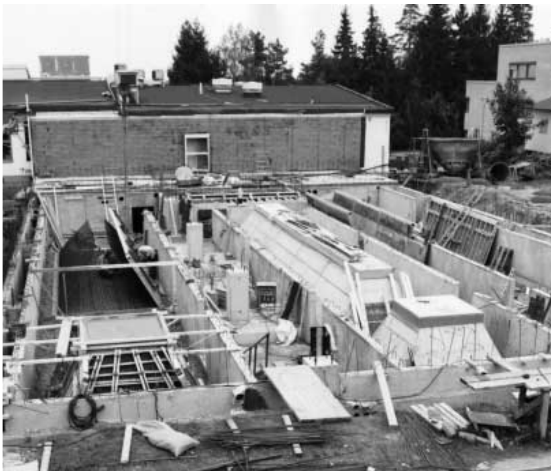
En stor och två mindre pirar är gjutna och armering och formning pågår på en större reservpir.
