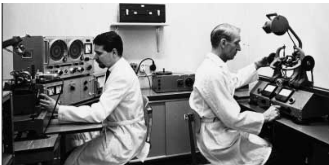
Hans Magnusson och Harry Höög i balanseringsrummet för gyrorotorer.
