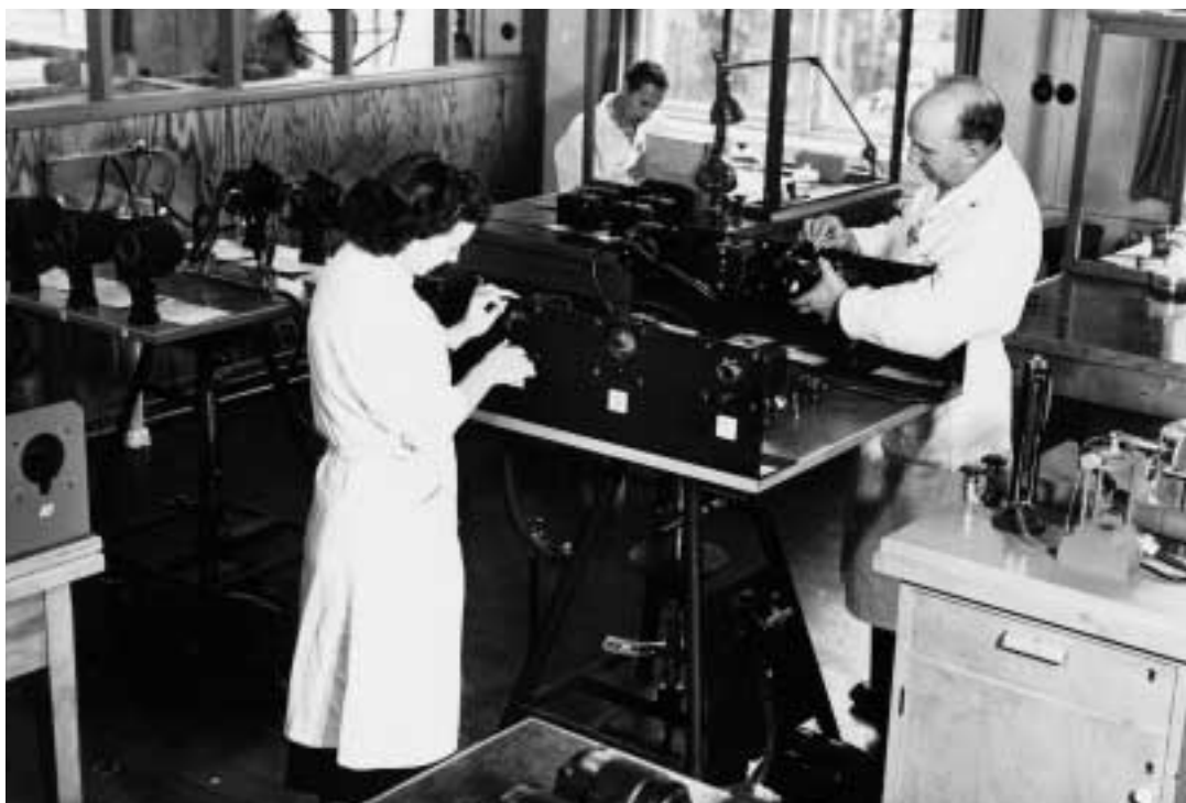
Eivor Sachs (sedermera Carlsson) och Uno Bärnström provar och justerar pneumatiska kursgyron. Vid arbetsbänken med glasburen syns Roland Lindell och genom glasväggen skymtar maskinverkstaden.
