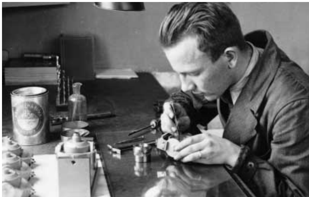
Bertil Johansson gör översyn på ett av de första pneumatiska horisontgyrona 1937. Foto ur Harald Larssons efterlämnade samlingar
