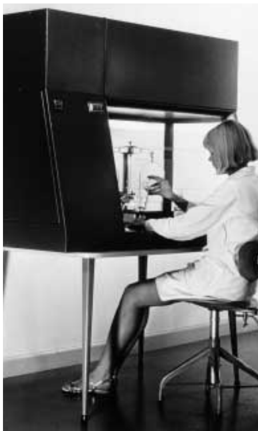
Apoteksbank med vertikalt luftflöde, som utvecklats och tillverkats på CVM.
