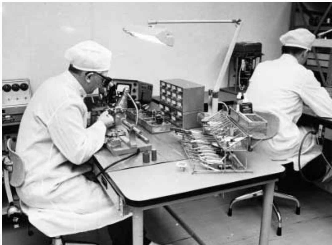
Olle Häggqvist i arbete med servokomponenter i rumsklass 4, på platsen framför Olle ett så kallat KZ-gyro till en motortorpedbåt.
