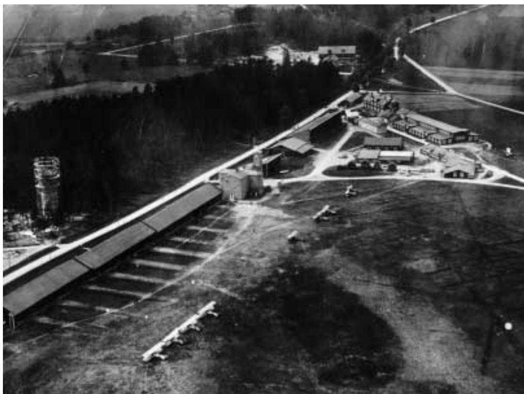
Verkstadsområdet 1924, vattentornet är under byggnad. Foto ur Celsius Aerotechs samlingar
