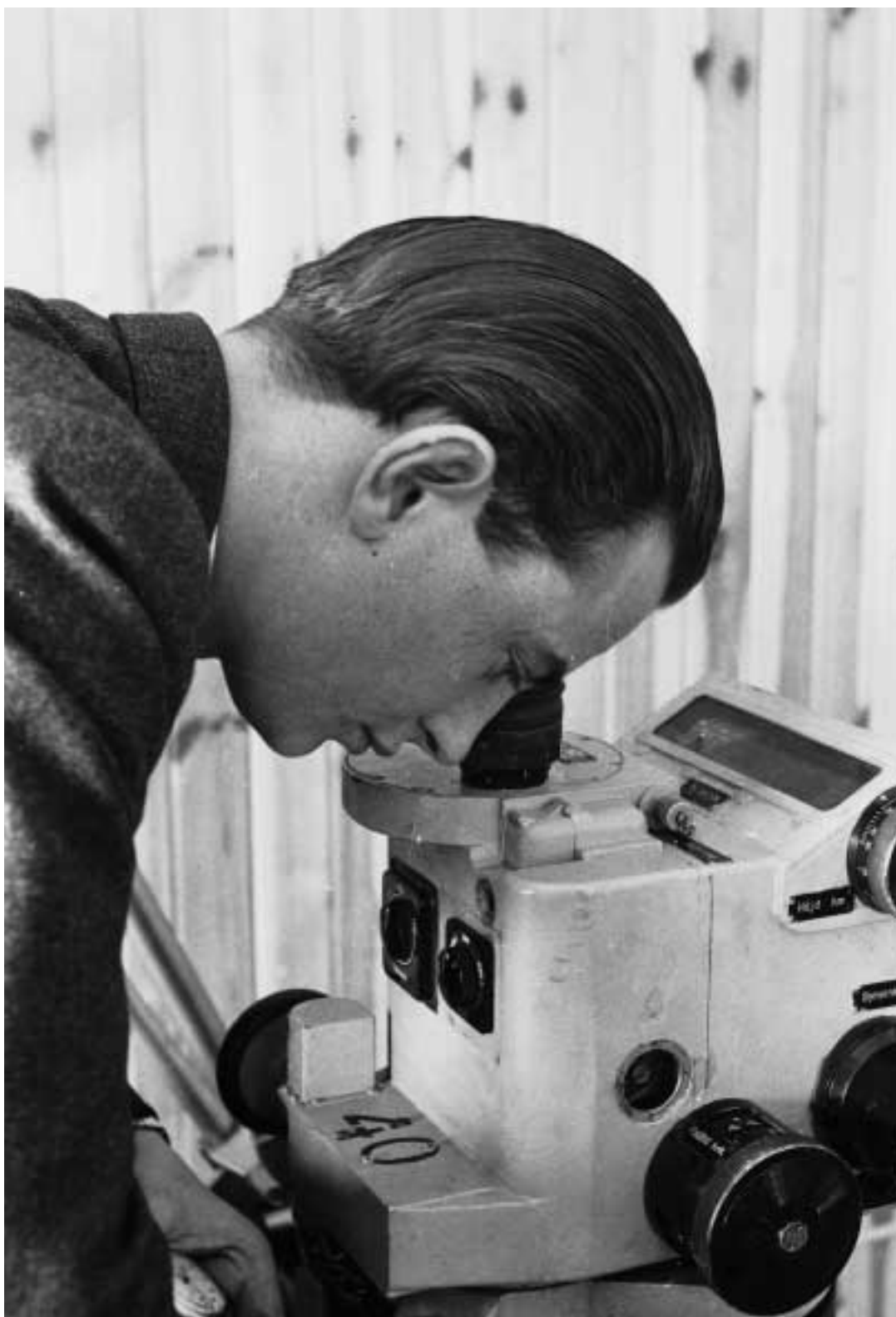
På IP 1943, Sten Skoog provar ett bombsikte av fabrikat Zeiss till fpl B 3, Junkers Ju 86. Foto: Sten Nordlund
