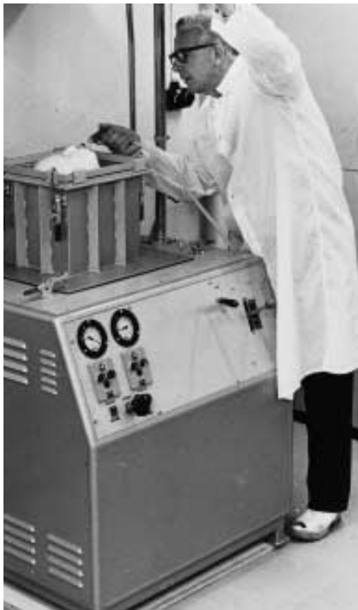
Olof Häggqvist lägger sista handen vid en CVM-konstruerad och tillverkad utrustning för vakuumformning av ansiktsmasker som användes vid tumörbehandling i mitten av 1960-talet.
