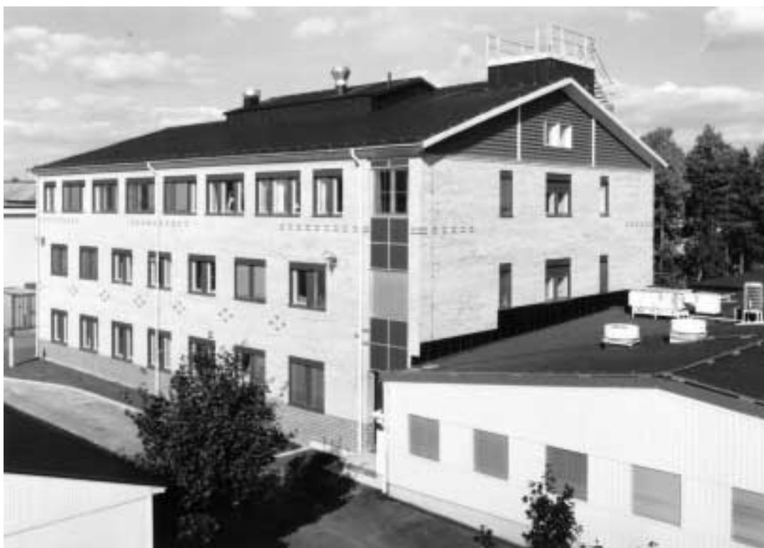
Det nya TN-huset som det såg ut sommaren 1989. Plattformen på taket är en förlängning av det gjutna hisschaktet. Detta arrangemang utgör en mycket stadig bas för optiska mätningar på stora avstånd.
