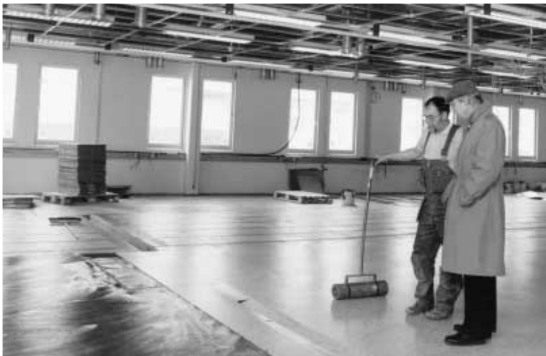
Läggningen av det statiskt avledande golvet har inletts. I taket skymtar det installationstäta utrymmet mellan valv och innertak som är en hel meter.
