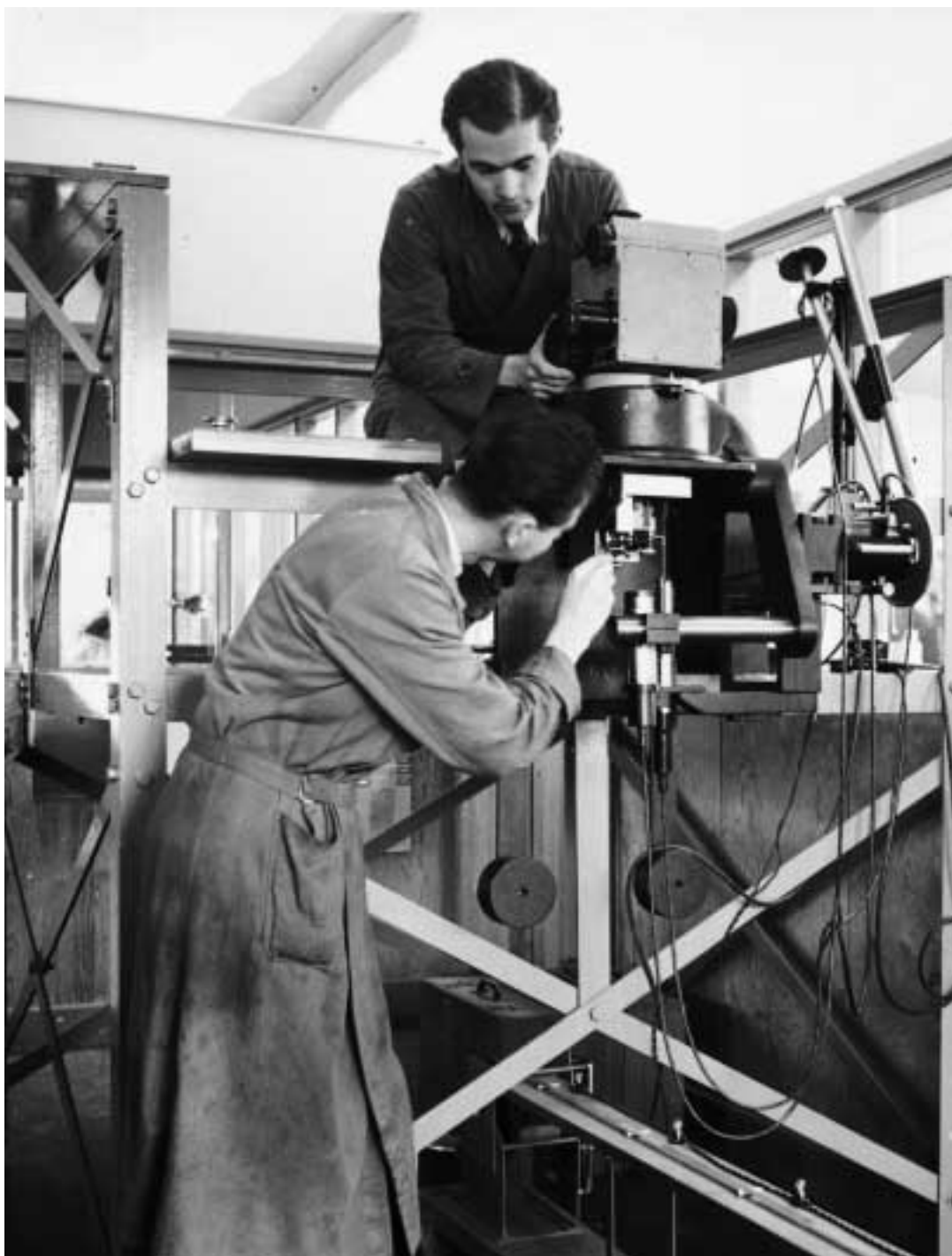
Astor Lindström (överst) och Arne Steen provar ett bombsikte av fabrikat Zeiss. Lindström och Steen arbetar i par med detta sikte, de var ensamma om detta uppdrag som hade hög status. Siktet var avsett för plan bombfällning och mätte via en centrifugalreglerad likströmsmotor och en mekanisk integrator fart, sidavdrift med mera. Provningsutrustningen på bilden, som är av Kilgers konstruktion, möjliggjorde injustering och kontroll av siktet. Det transportbandsliknande anordningen i bildens underkant beskådas genom siktet och en försättslins varvid markens rörelse i förhållande till flygplanet simuleras. Foto: Sten Nordlund
