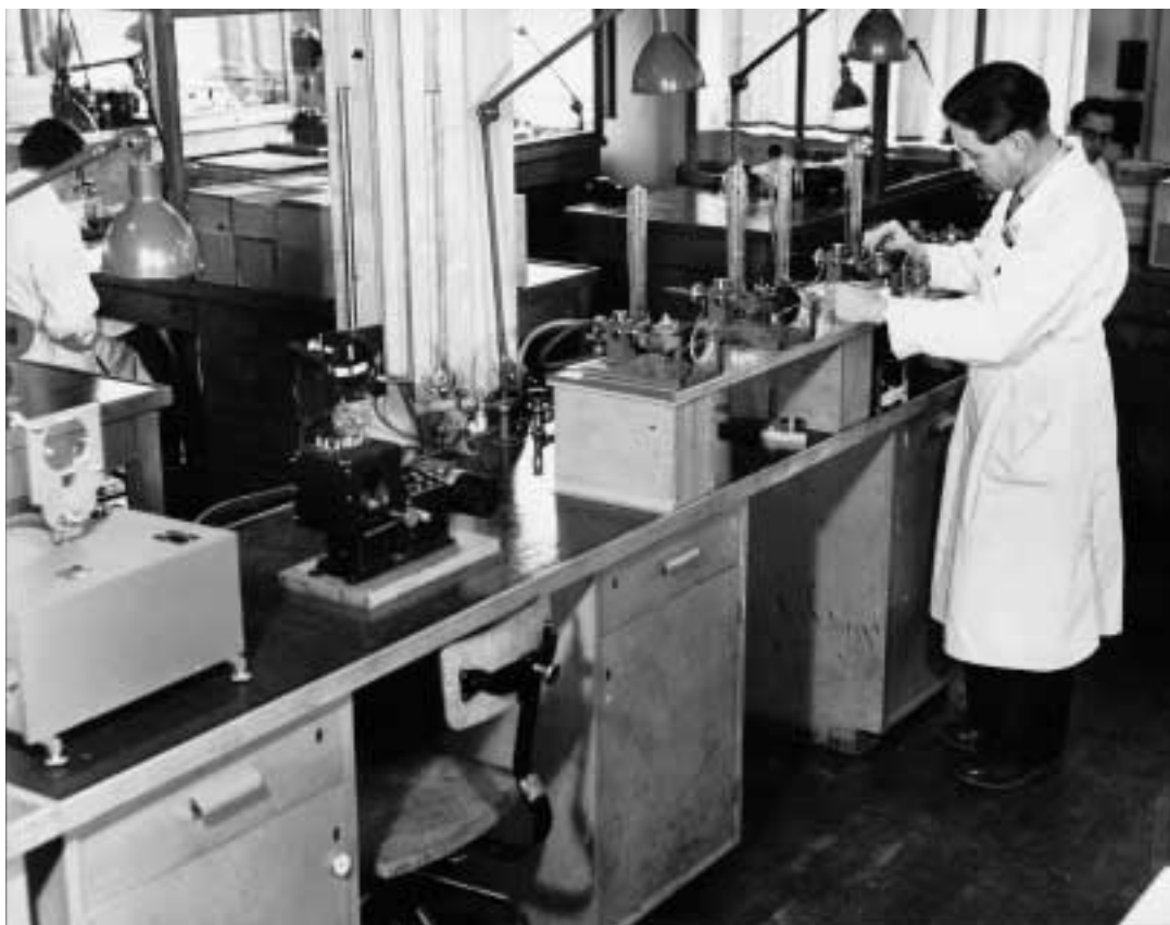
Nils Wictor provar invandringstider på delmonterade horisontgyron, i bakgrunden Folke Wrigsjö.
