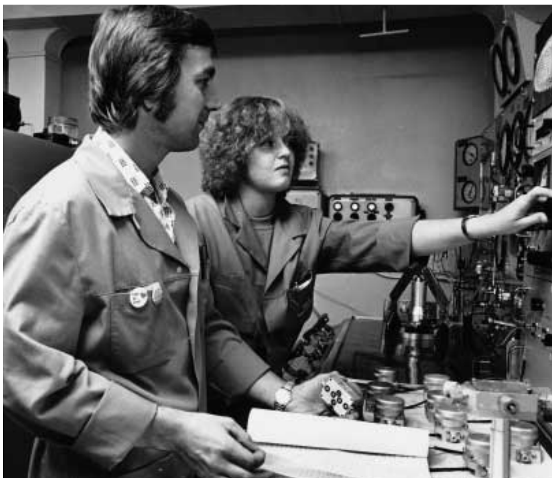
Karin Viklund provar, en servoventil till styrautomat 04 fpl 32, under överinseende av kontrollanten Curt Hahn.
