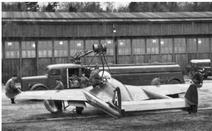
Ovan: Tankbil 11 m 3 som började komma i tjänst 1951 var till en början speciellt anpassad för tankning av Vampire, med tre slangar som drogs ut från en bom. Pump och filter satt i dragbilens hytt. Här demonstreras tankning av J 28B vit Adam från F 10.
